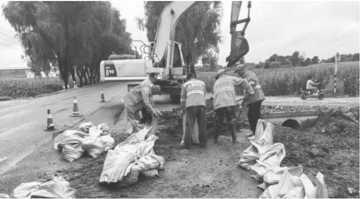
养护人员排除路面淤泥 省交通运输厅供图
