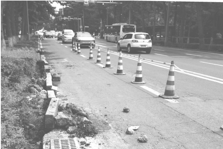
施工现场 本组图片 城市晚报全媒体记者 刘佳雪 摄
