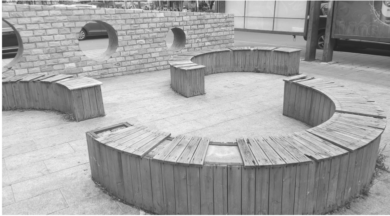
小广场上的座椅多处损坏 城市晚报全媒体记者 吕闯 摄
