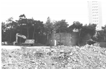
施工场地正在平整恢复
