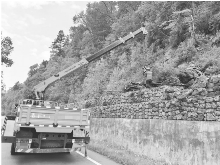
加固公路基础设施 省交通运输厅供图
