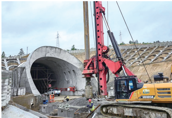
路基接触网钻孔 项目部供图
