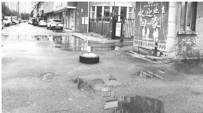
路面坑洼影响出行 城市晚报全媒体记者 刘佳雪 摄
