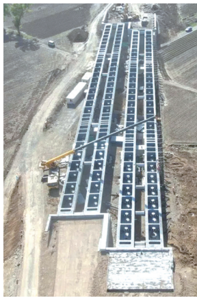
大桥钢箱梁架设完成
