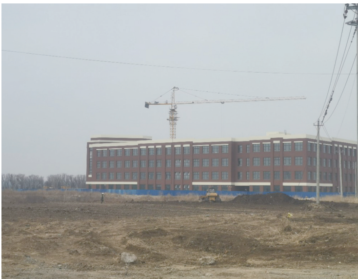
一期工程一标段已完成主体封闭 城市晚报全媒体记者 吕闯 摄
