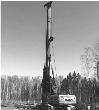
打桩机进行桩基施工
