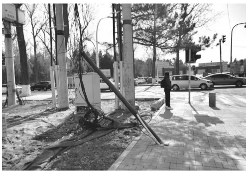
现场存在安全隐患 城市晚报全媒体记者 刘佳雪 摄
