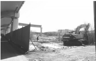
大型机械进驻现场
