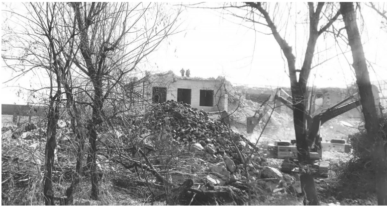
现场正在拆除作业 本组图片 城市晚报全媒体记者 刘佳雪 摄
