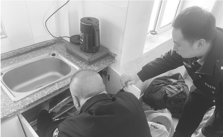
民警帮助低保户解决室内漏水难题 警方供图
