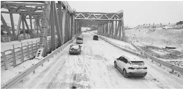
长春市主城区与莲花山之间又多了一条重要交通通道 项目部供图
