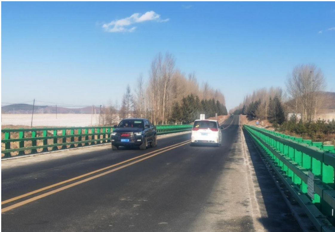
国道G201鹤大线沙河桥改建工程通车 省交通运输厅供图
