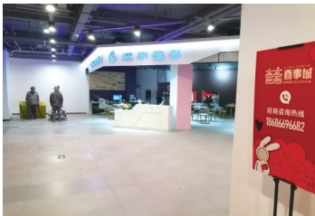
商场内部改造中
