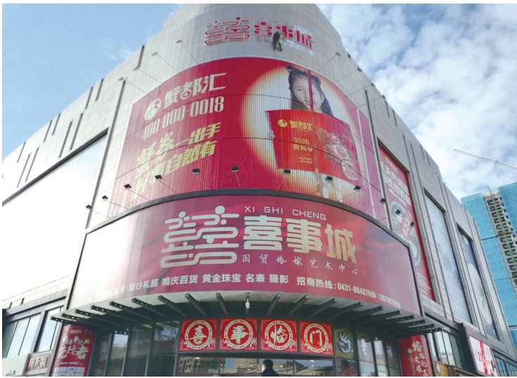
施工人员在更换牌匾 本组图片 城市晚报全媒体记者 刘佳雪 摄
