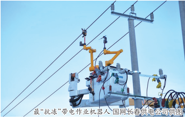
最“抗冻”带电作业机器人 国网长春供电公司供图
