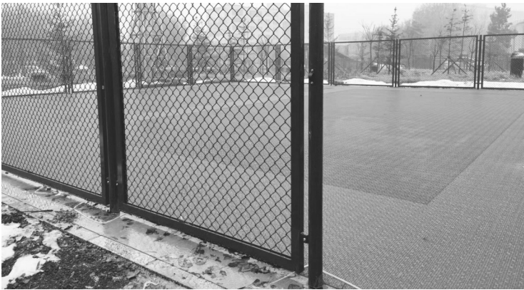
正在建设的健身场地 长春市体育局供图
