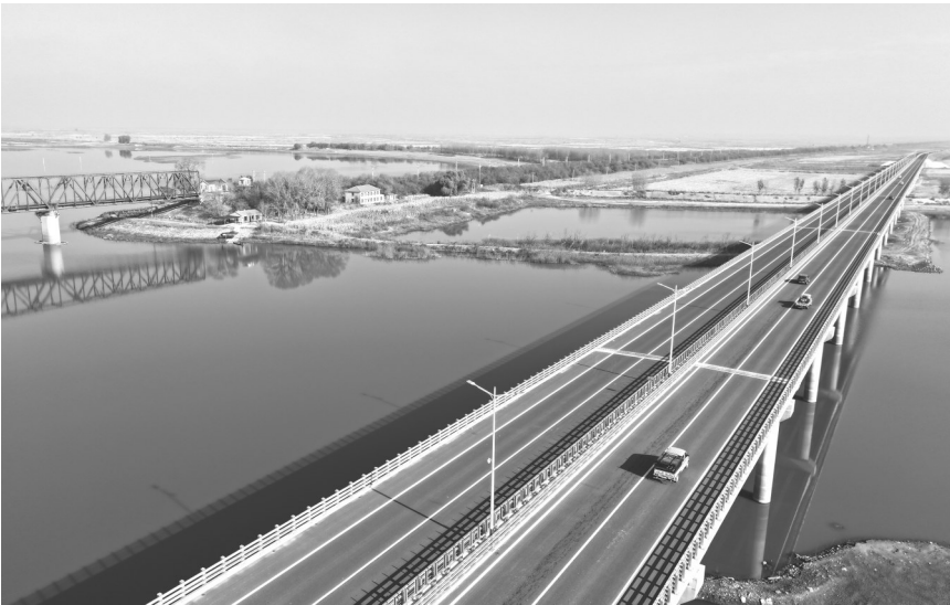
大安嫩江大桥通车 大安市交通运输局供图
