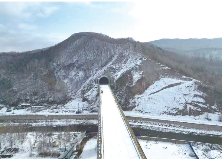
白山隧道顺利贯通 长春站供图
