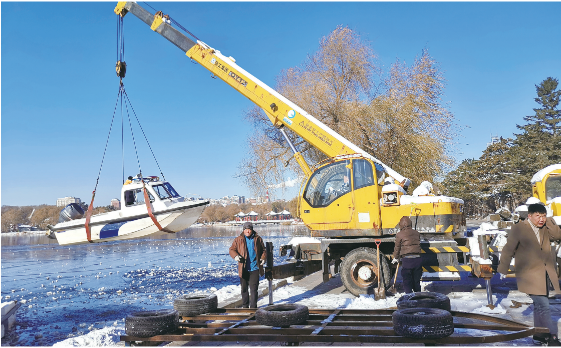
吊车将救助艇吊起 城市晚报全媒体记者 吕闯 摄
