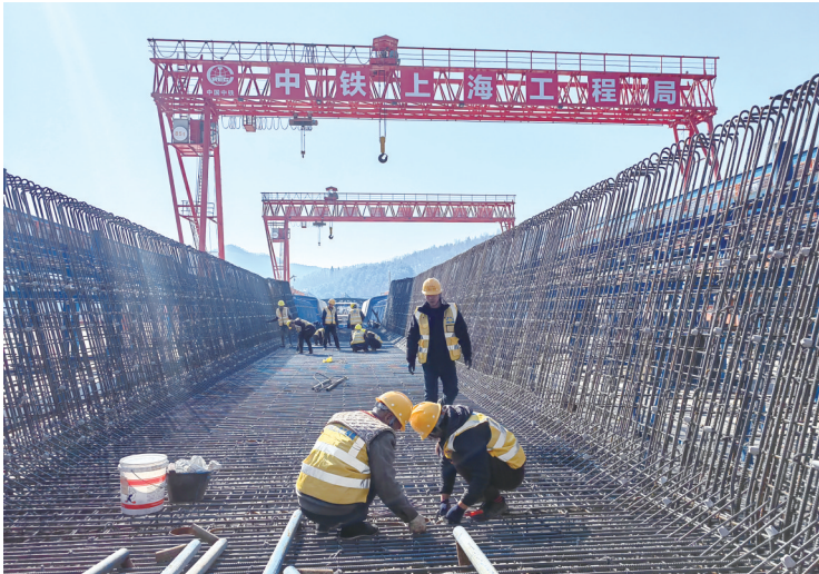
施工现场 项目部供图
