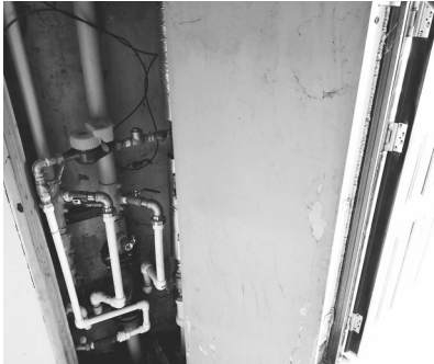
新水表很大(左图),管道井关不上门(右图) 城市晚报全媒体记者 刘佳雪 摄
