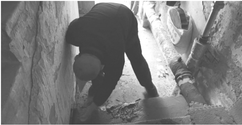
破损的台阶用水泥重新进行修复 社区供图
