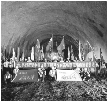
贯通现场 项目部供图
