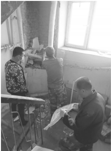
倾斜的墙体被拆除 社区供图
