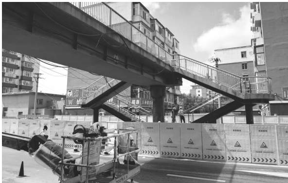
过街天桥北侧施工现场 城市晚报全媒体记者 刘佳雪 摄
