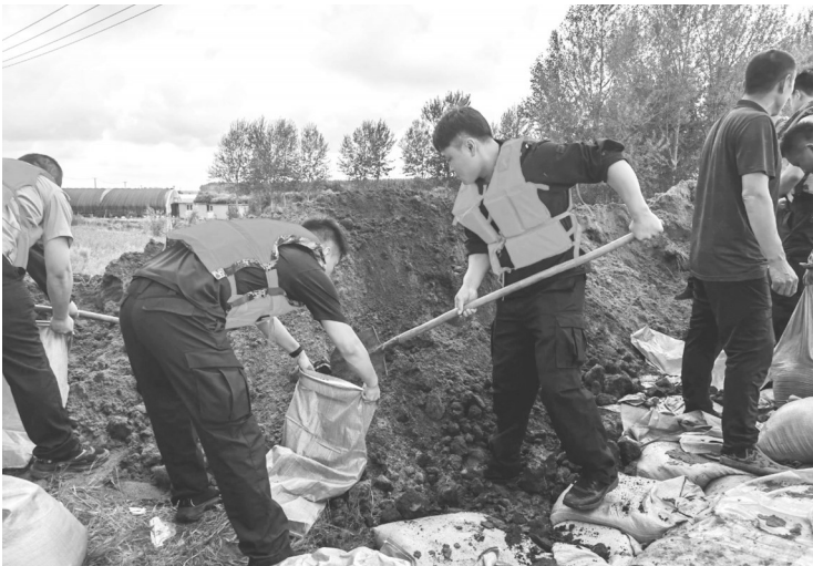
民警加固堤坝 警方供图
