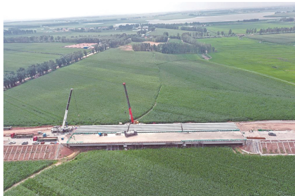
建设中的长太高速公路项目 省交通运输厅供图
