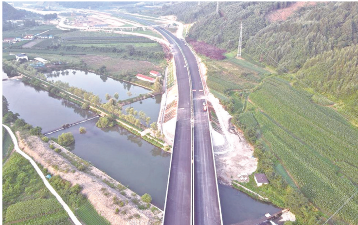
建设中的集桓高速公路项目 省交通运输厅供图
