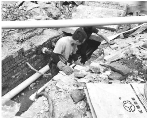
管道进行了更换 本组图片 社区供图
