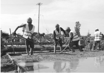
工人正在施工
