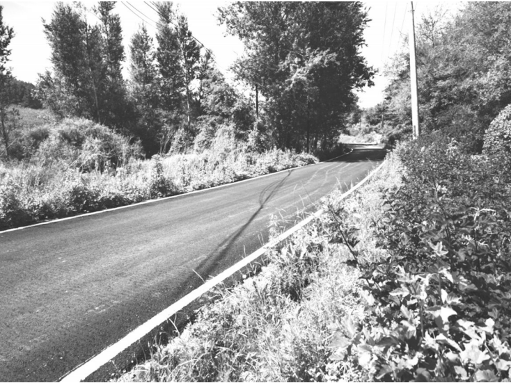
平坦的沥青路投入使用 本组图片 省交通运输厅供图
