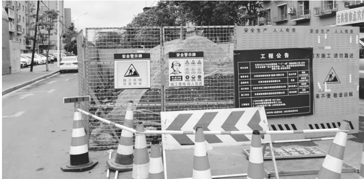
管网改造施工现场 城市晚报全媒体记者 刘佳雪 摄
