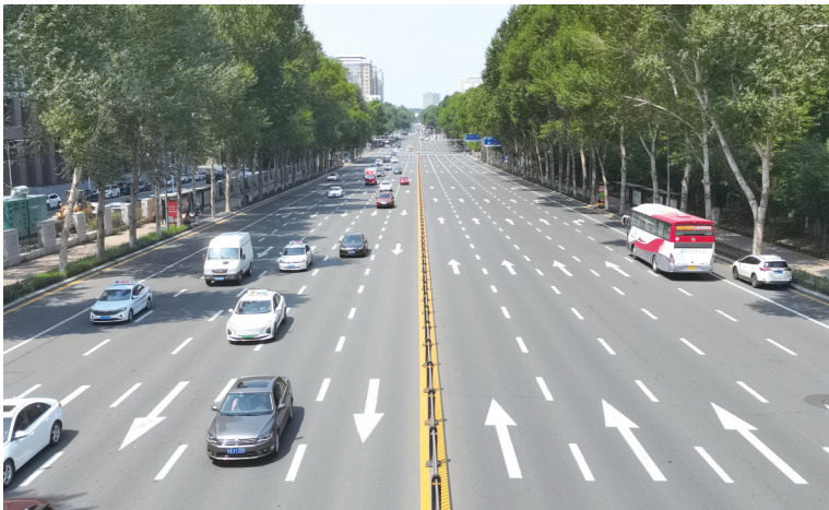
自由大路部分路段已经拓宽 城市晚报全媒体记者 陆续 摄
