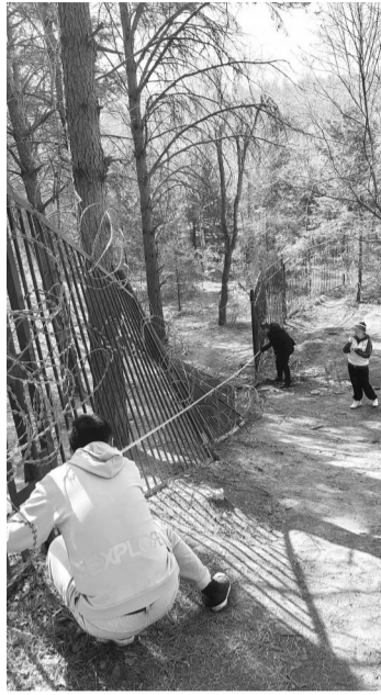
景区工作人员准备重新安装栅栏 净月潭景区供图
