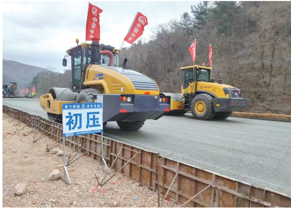
压路机完成摊铺 吉高集团供图
