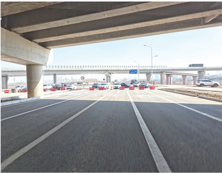
新开通的道路指示标识和信号灯都已设置完毕 城市晚报全媒体记者 陆续 摄
