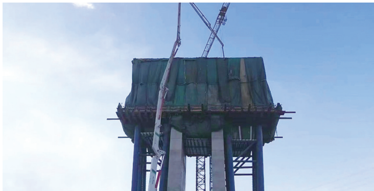
施工现场 项目部供图
