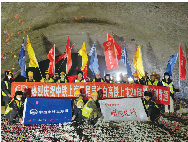
施工人员庆祝隧道顺利贯通 项目部供图
