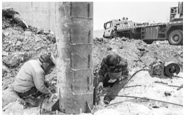
工人在焊接作业
