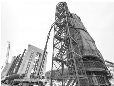
白山浑江特大桥全封闭保温浇筑墩身混凝土
