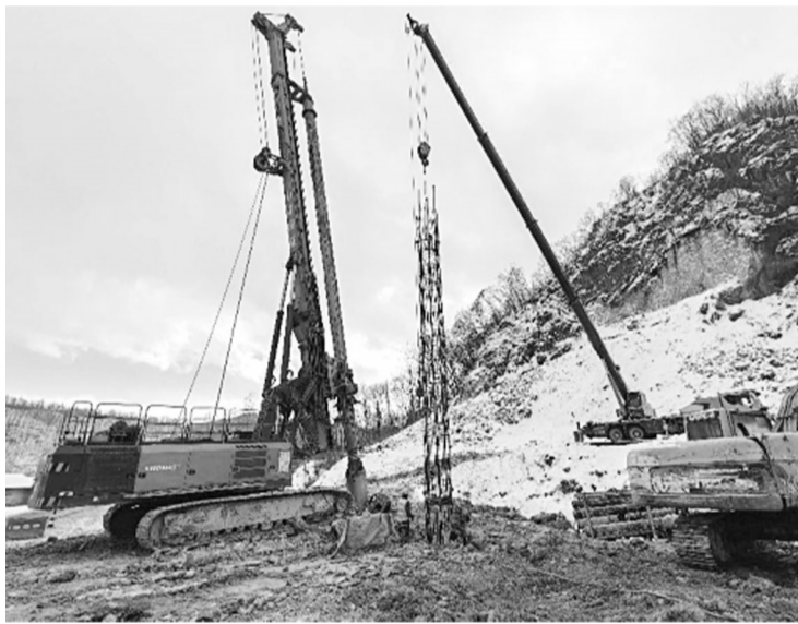
岔沟门大桥钻孔桩下钢筋笼 本组图片 项目部供图
