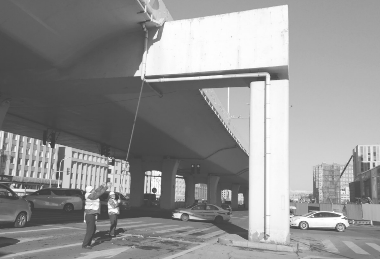
工作人员在高架桥下进行除冰作业 城市晚报全媒体记者 刘佳雪 摄
