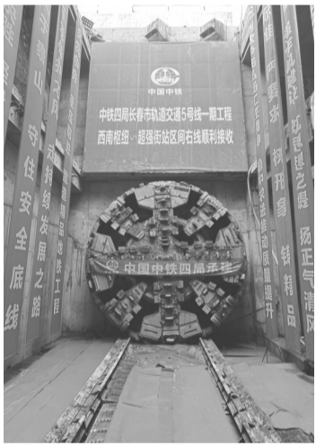
施工现场 长春轨道交通5号线二工区项目部供图
