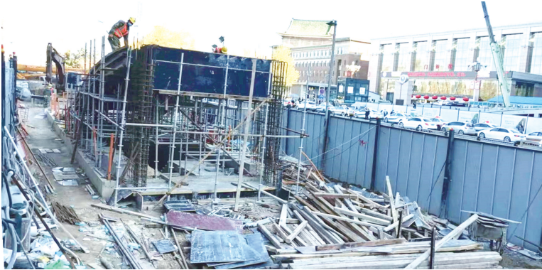
过街通道部分模板支设正在进行中 城市晚报全媒体记者 刘佳雪 摄
