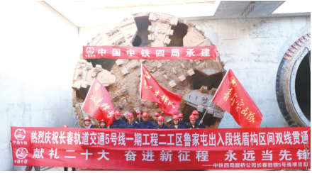
盾构区间双线贯通 长春地铁5号线项目部供图
