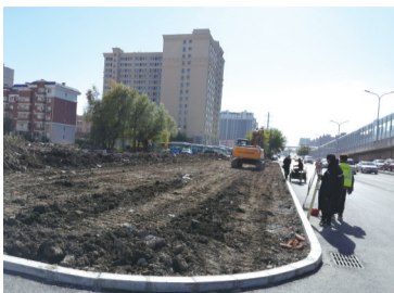
施工人员正在测量作业
