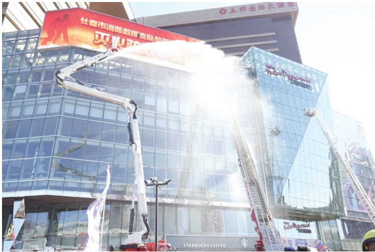
高喷射消防车和云梯消防车齐出动 消防供图
