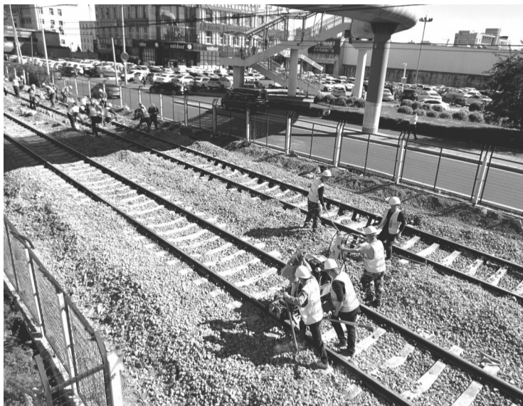
对钢轨进行打磨作业 城市晚报全媒体记者 刘佳雪 摄
