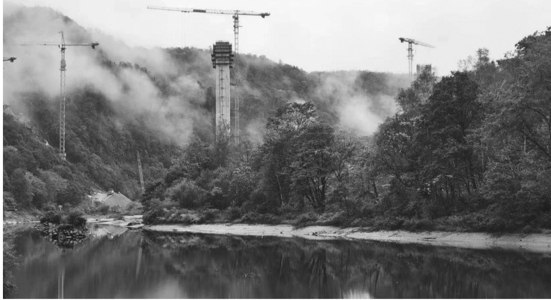
头道松花江特大桥9号墩浇筑完成封顶 长春站供图
