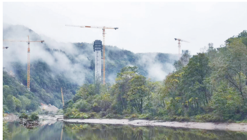
头道松花江特大桥9号墩浇筑完成封顶 长春站供图
