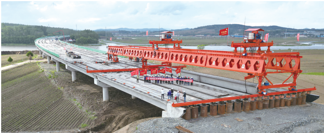
完成辉发河大桥箱梁架设
